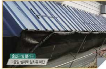
축사 입구 그물망 설치
