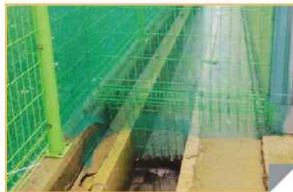
배수구 그물망 설치
